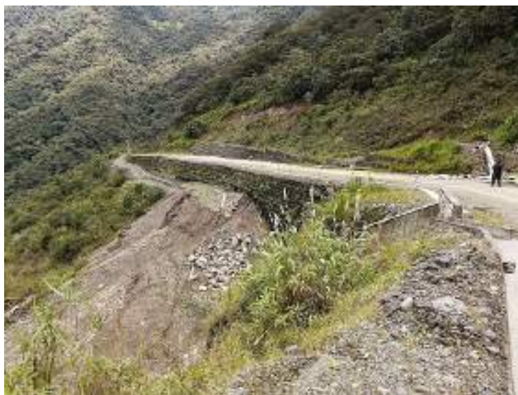
Figura 4-2 Vista de la parte media del área del deslizamiento investigado donde la carretera fue afectada (cortada) y reconstruida empleando muros de contención de tierra armada. En esta zona, el deslizamiento se encuentra aún propenso a continuar con una tasa de desplazamiento baja, según los técnicos de CELEC-EP. Se puede observar también la fuerte pendiente que domina todo el entorno.
