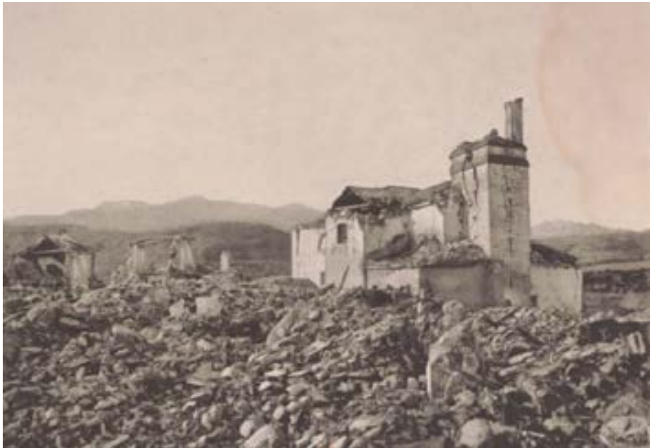
△ La iglesia de Arenas del Rey rodeada de escombros. Fotografía tomada por los comisionados franceses.
