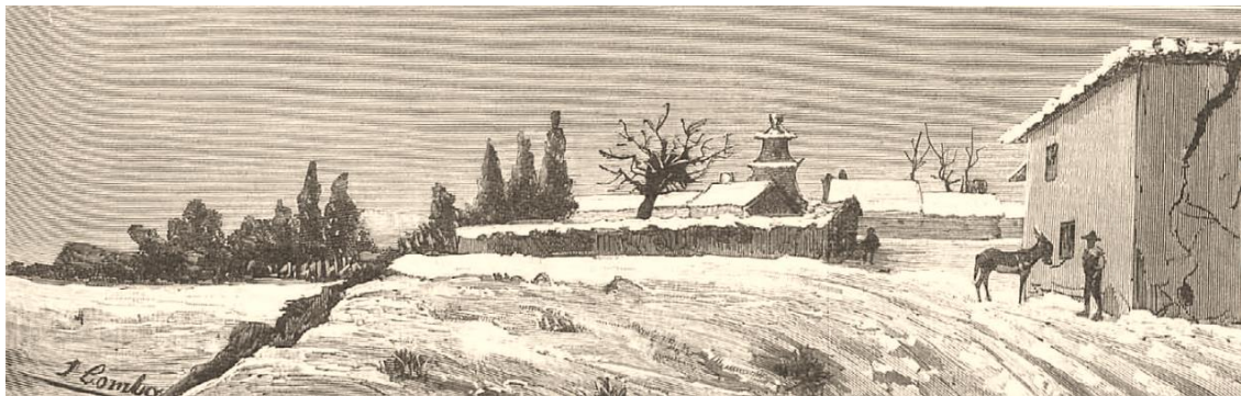
Güevéjar: grietas del terreno a la entrada del pueblo. Ilustración Española y Americana (30.I.1885).
