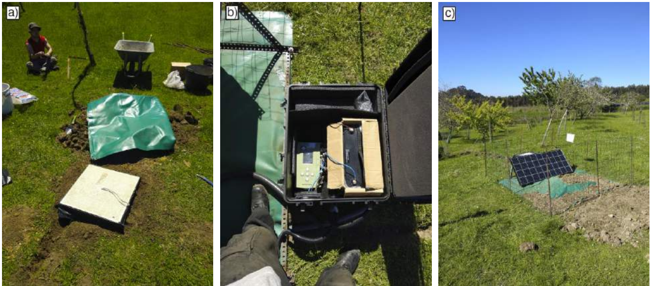
Figura 4. 7. Ejemplo de estación sísmica de la red GEOCSN instalada en el campo (OLES, en Oles, Villaviciosa, Asturias): a) Vista de la arqueta semienterrada que contiene el geófono Trillium 120 PA; b) Vista de los equipos contenidos en la caja impermeable exterior: digitalizador y batería 12V; c) Vista exterior de la estación.
